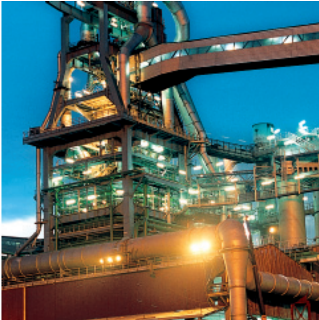
Aplicación industrial: Refinería
