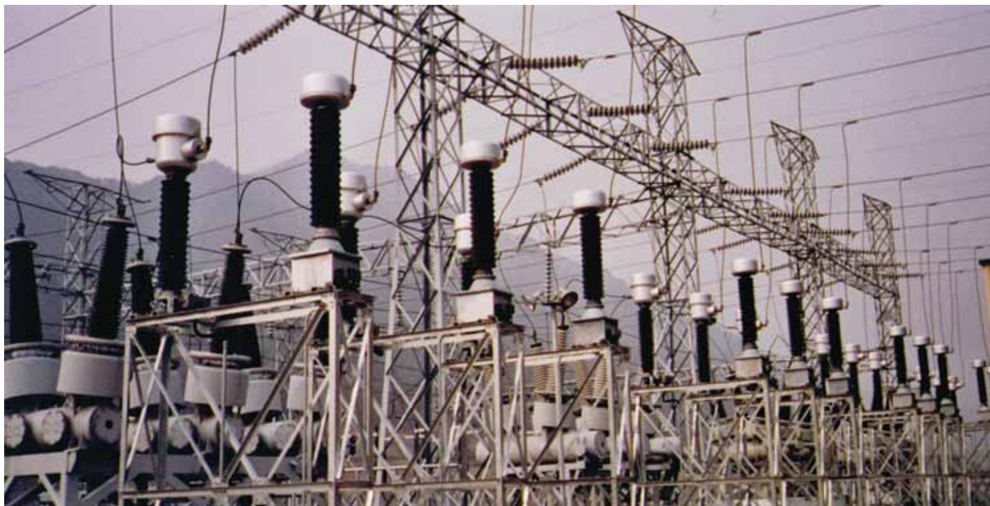
Transformadores de Intensidad y de Tensión Inductivos de 145 kV para zonas de gran altitud.
