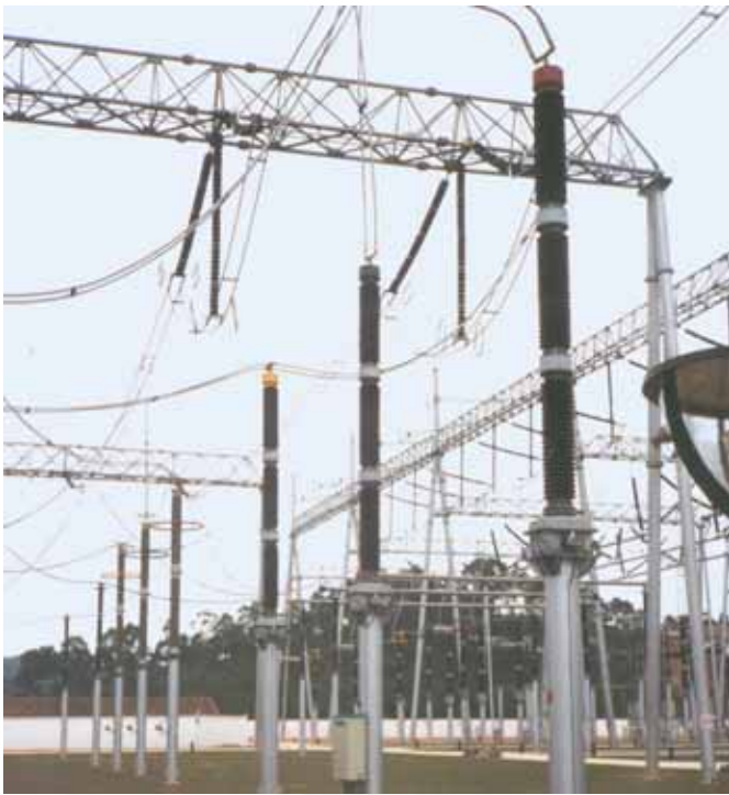
Transformadores de Tensión Capacitivos de 550 kV en interconexión de corriente continua (H.V.D.C.). Diseñada por Siemens Alemania para State Power South Company (China).
